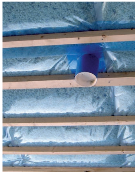
Höyrynsulun läpivienneissä käytetään läpivientikappaleita.
